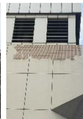
批刮腻子找平，必定龟裂脱落
